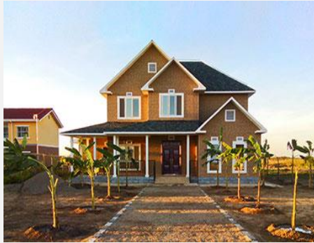
المساكن عالية الجودة في زامبيا (~4000 وحدة، 2013)
